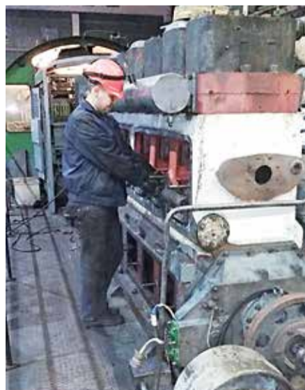
■ Монтаж оборудования на дизель-генераторную установку тепловоза ТЭМ2-2731.
